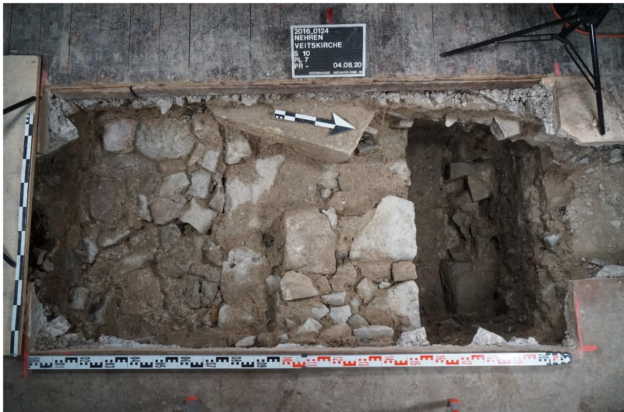
Abb. 1 An die Nische vor dem Chorbogen der Kirche von 1430 zieht eine massive Flächenfundamentierung. Hier dürften wir den Standort von etwas Schwerem fassen können, vermutlich dem Taufstein. Nördlich der Kirchenwand ist ein parallel verlaufendes Mäuerchen zu sehen, das einen in Fachwerk ausgeführten Eingangsvorbau zur Vorgängerkirche getragen haben kann.
