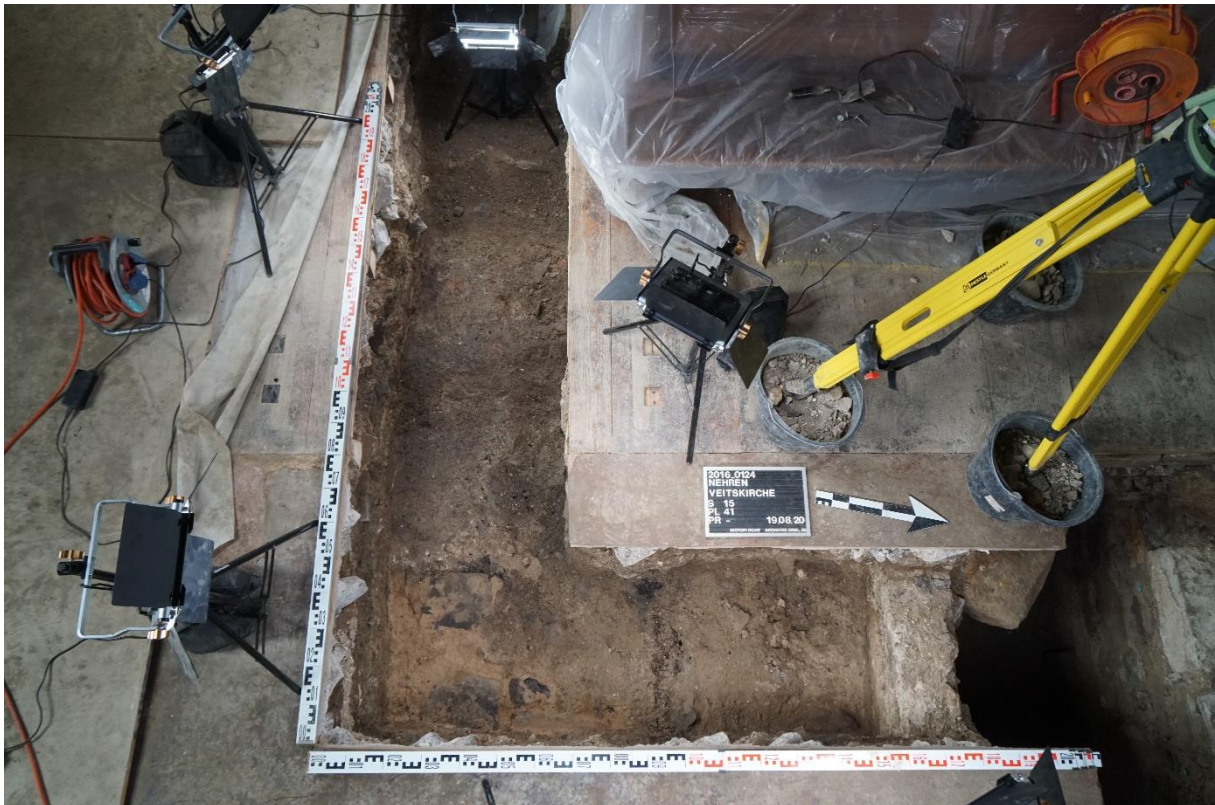
Abb. 4 Am letzten Grabungstag kam das Ostfundament des Langhauses des ersten Kirchenbaus zum Vorschein – es füllt den vorderen Schenkel des winkelförmigen Schnitts ganz aus, ist jedoch hier und da noch unter jüngeren Auflagen verborgen – bei 60 cm Tiefe war hier Schluss!
