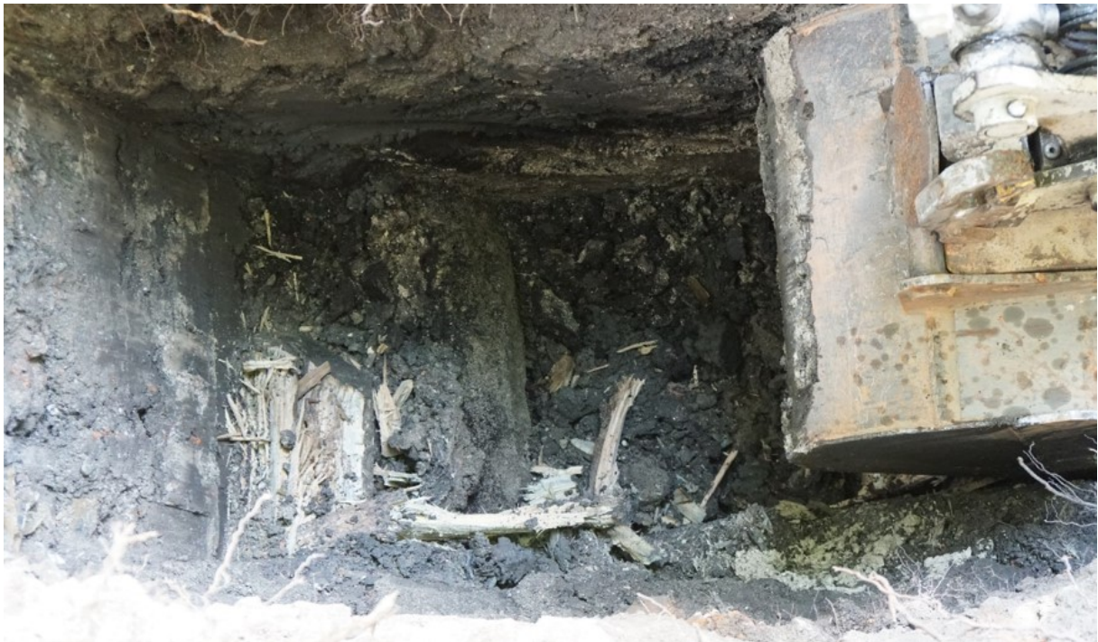
Abb. 5 Baubegleitung 2019-0428: Der Bagger schneidet tief unter dem damaligen Parkplatzniveau Reste einer Konstruktion aus grob zugerichteten Eichenbalken an. Blick gg. WSW.
