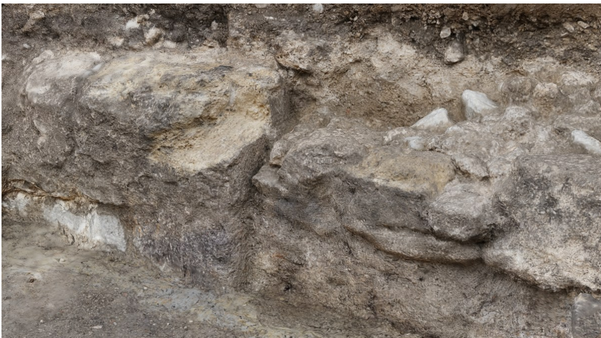
Abb. 11 Bad Urach, HWS Erms BA4 arch 7, S1 PL1/PR2 Ausschnitt aus 3D-Modell: An das ältere Turmeck (10) in der linken Bildhälfte setzen zweiphasig nach rechts (OSO) weiterlaufende Mauern an, beide mit leichtem Rücksprung. Fugenlos und damit wohl bauzeitlich die untere Tuffquadermauer (21), mit deutlich erkennbarer Fuge die jüngere Zwingerturmmauer (14).
