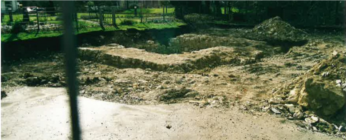
Abb. 14 Bad Urach, 2000_0338_ehem. Wasserburg. Von städtischer Seite übermitteltes Foto des Turmbefunds vom Frühjahr 2001.
