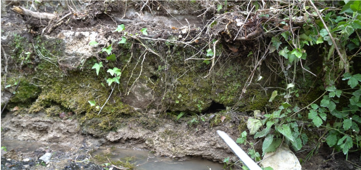
Abb. 21 Bad Urach, HWS Erms BA4 arch 7. Videoschnappschuss aus Schnitt 4: Fuge zwischen gewachsenem Tuff und der ältesten Kanalmauer (1 Lage kleinere Tuffsteinquader), darüber mit Zementmörtel verfügte Neusetzung des 20. Jahrhunderts mit wesentlich größeren, grob gesetzten Tuffquadern.
