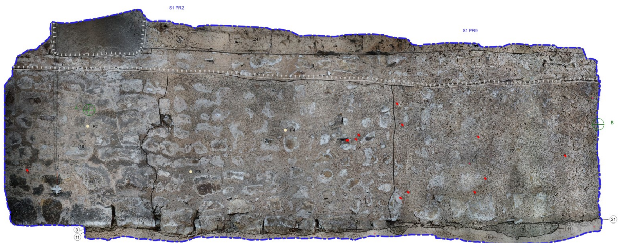
Abb. 5 Profil 2/9. Älteste Partie ist das Mittelstück (20) der Südostwand mit seiner tief reichenden Uk.
