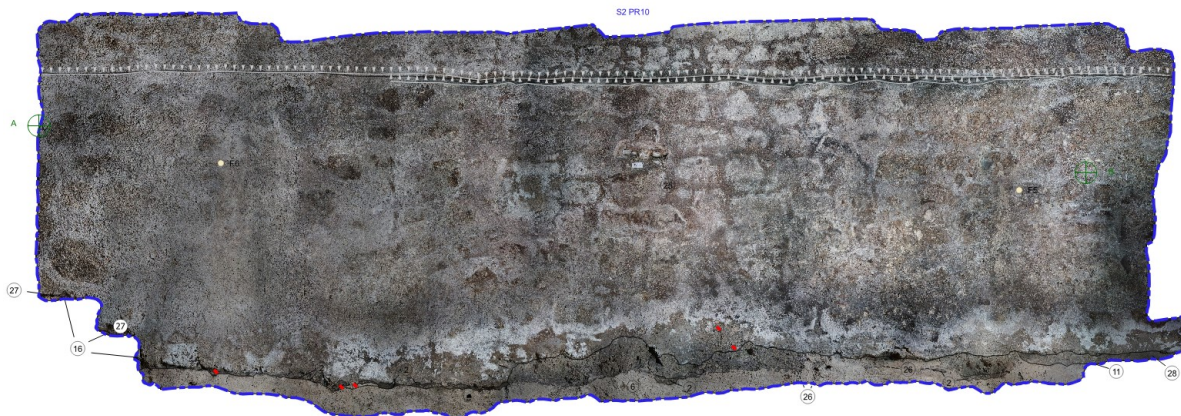
Abb. 6 Profil 10. Trotz seiner deutlichen Ausbauchung zur Raummitte scheint Nordwestmauer (25) einphasig zu sein – und zum Bau des Kellers der 2. Hälfte des 16. Jahrhunderts zu gehören.
