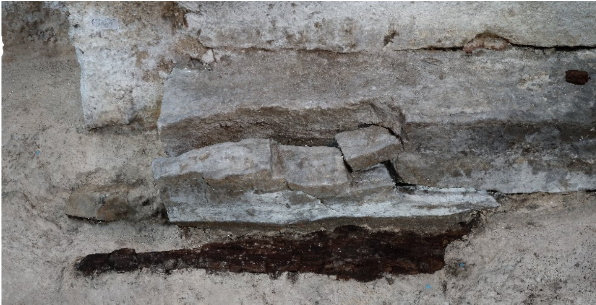
Abb. 7 Ausschnitt aus 3D-Aufnahme zu Planum 15. Asymmetrisch unter Kellertreppe (16) liegt Holzschwelle (14), die in der 2. Hälfte des 16. Jh. den Treppenaufgang zum Keller unterhalb des Hauptbaus des späteren Alten Oberamts fundamentierte.
